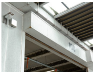
ラッカス製品によって無線 LAN 化
